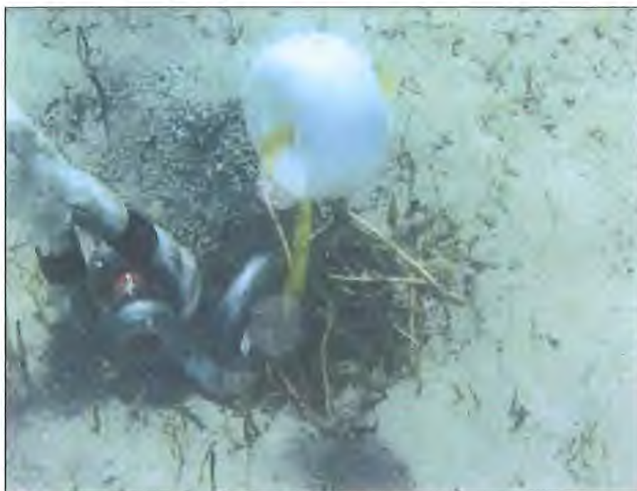
Figura 4. Aspecto final de un anclaje Manta Ray
